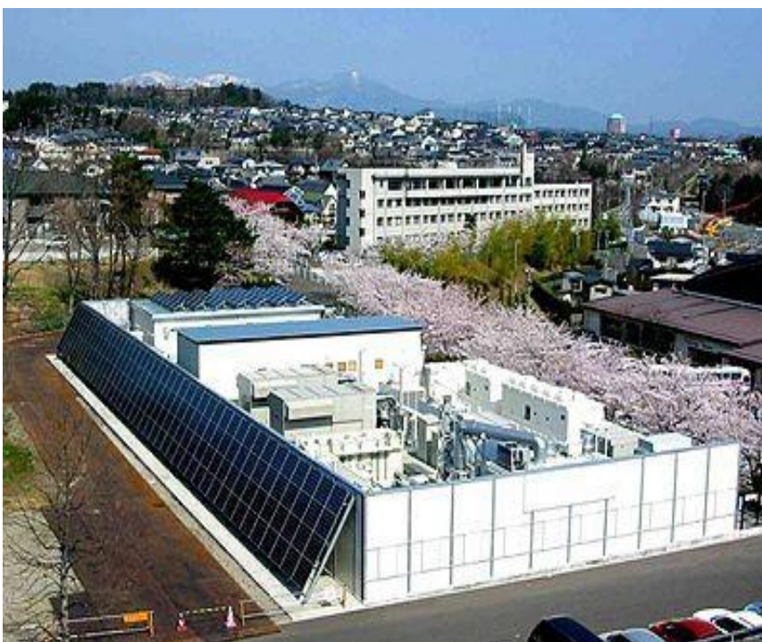
Photo d'un micro-réseau local, le Sendai Micro-grid, situé sur le campus de l'université Tohoku Fukushi dans la ville de Sendai dans le district de Tohoku au Japon. Source: Installations NTT. http://en.wikipedia.org/wiki/Distributed_generation
