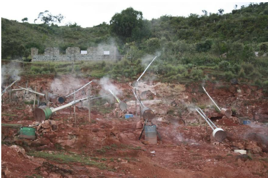
La vapeur géothermique est condensée et convertie en eau douce pour la production agricole à Eburru, Kenya. Crédit Photo Robert Foster, Winrock International.
