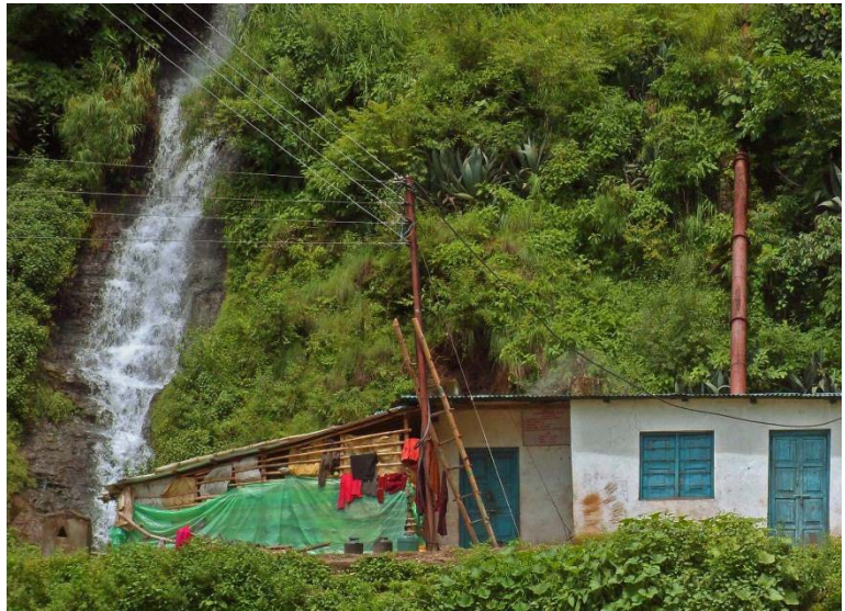
Cette image d'une opération micro-barrage située au Népal montre l'alimentation de la conduite forcée dans la centrale électrique, alors qu'un cours d'eau continue de s'écouler le long de la centrale. Crédit Photo: Winrock International.
